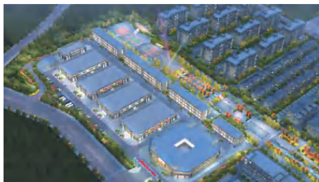
双柏安曼物流产业园区（昆明分公司）
